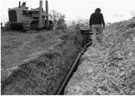
Fig. 1A.3 : une section du fossé EDF-GDF creusé dans des carbonates à débit en plaquettes de l'Oligocène.
