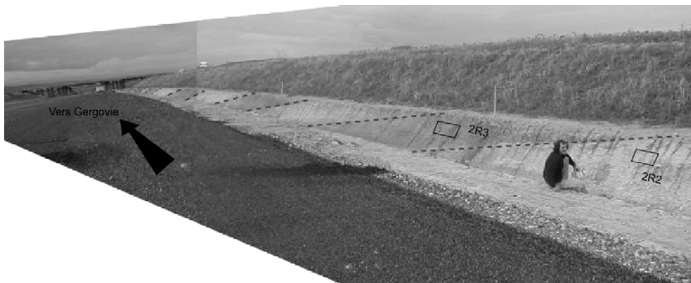
Fig. 1A.4 : alternance de passées métriques à plurimétriques de marnes marron/beiges et beige clair de l'Oligocène dans le talus de la nouvelle route reliant Gergovie à Orcet.
